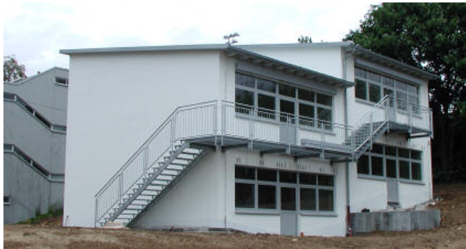
Die Bauarbeiten an den vier neuen Klassenräumen der KSS sind fast abgeschlossen.
